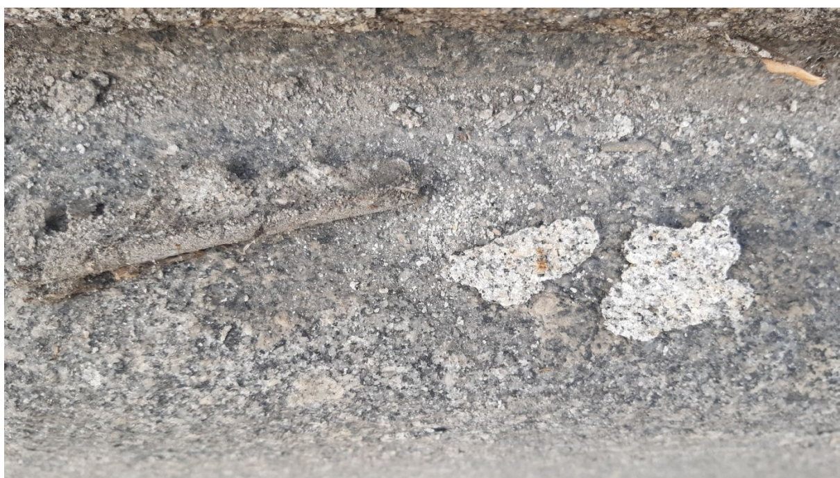
Uvolněné spáry a hrany žulových bloků.
